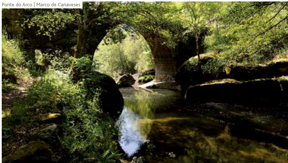
Ponte do Arco | Marco de Canaveses
